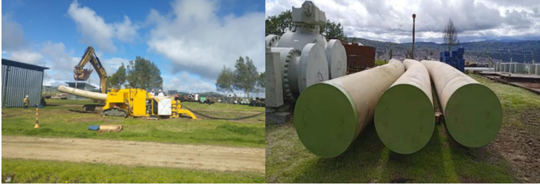
Doblado de tubería de 30"
