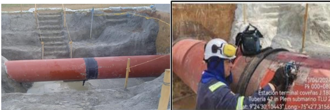
Inspección de validación en oleoducto submarino sección onshore PK 0+080 del Terminal Marítimo Coveñas.
