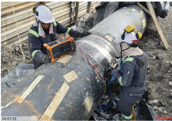
| Reparaciones mecánicas fisuras PK 182+604 | Excavación de alivio PK 182+604 tubería aliviada
