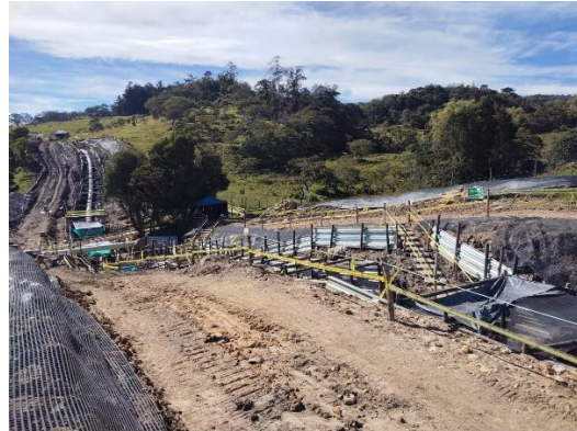
| Reparaciones mecánicas fisuras PK 182+604 | Excavación de alivio PK 182+604 tubería aliviada
